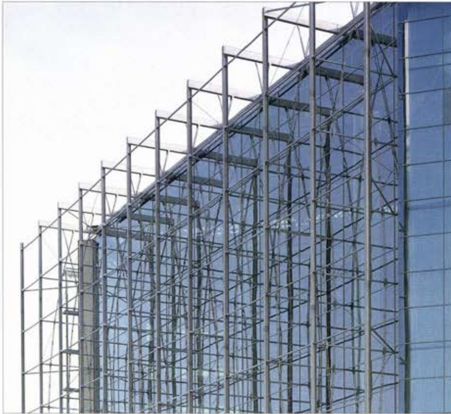
Sanoma Osakeyhtiö, Helsinki. Pohjoinen julkisivu lasikuulapuhallettu AISI316-teräsrakeenne.
