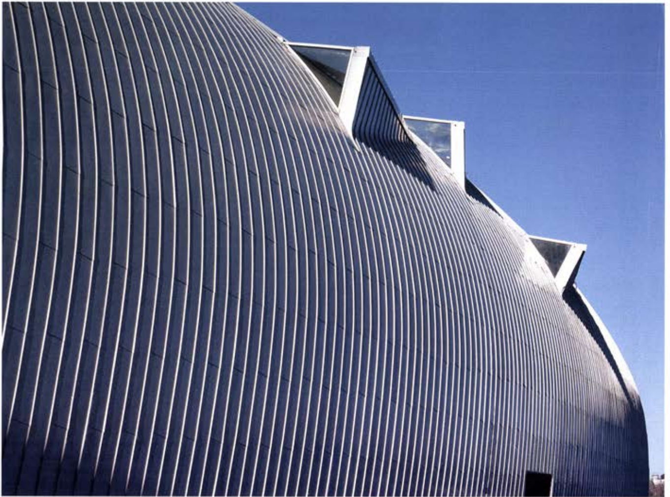
Kiasma Nykytaiteen museo, Helsinki. 500/0.80 mm seisovalla kulmasaumalla saumattu esipatinoitu Rheinzink. Peltirivit on kallistettu pystysuorasta vinoon 7°.
